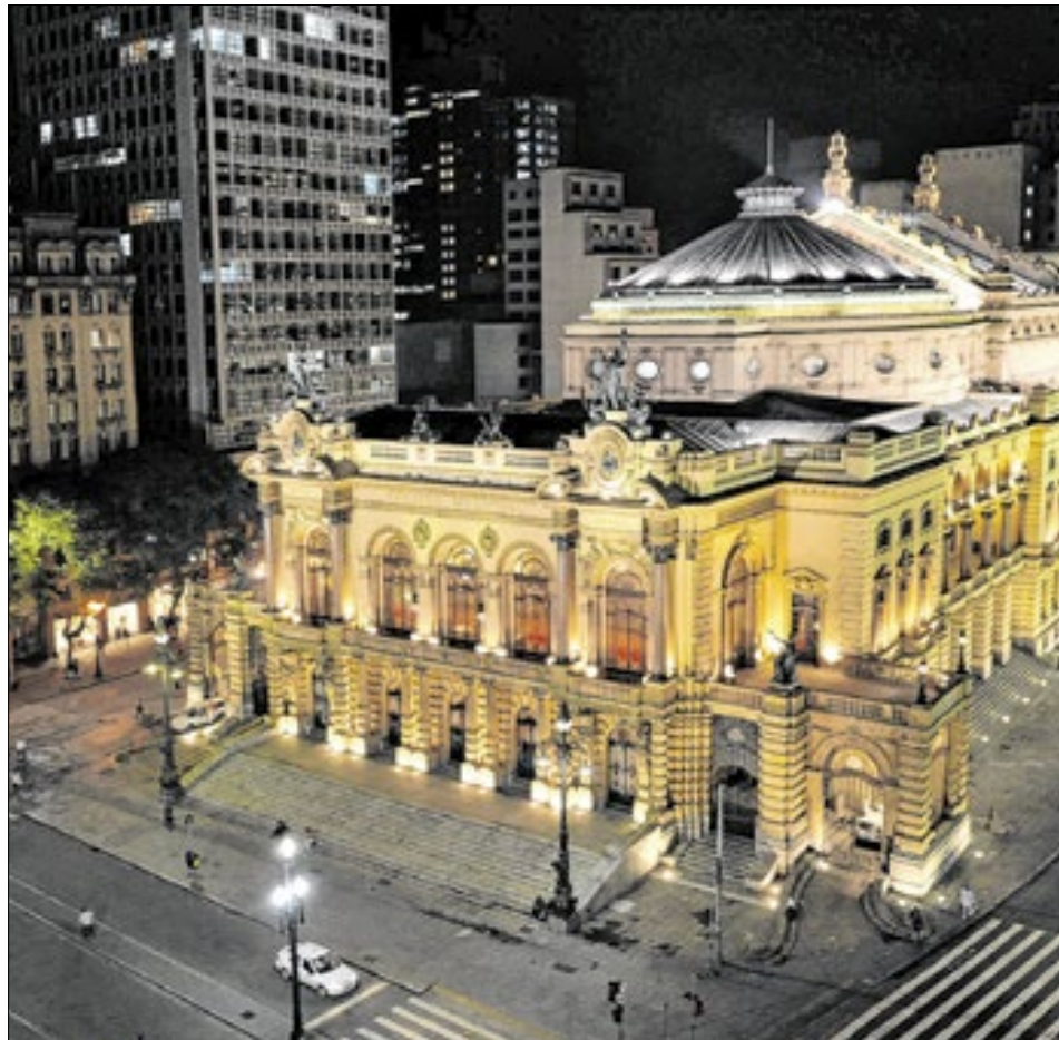
O percurso inclui locais como o Theatro Municipal (foto), o Viaduto do Chá, a sede da Prefeitura, a Praça do Patriarca, e outro.
