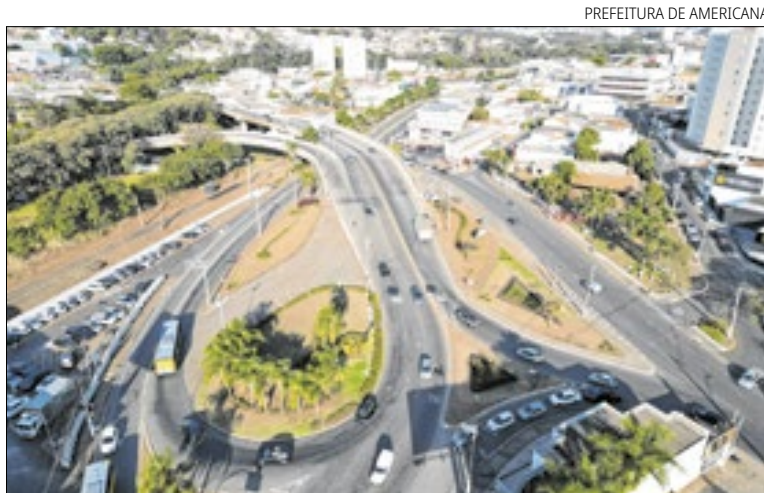
Obras começam nesta quarta-feira e terão serviços durante a madrugada
