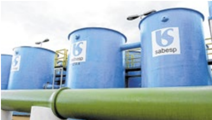
Obras protegem Represa Billings e ampliam saneamento
