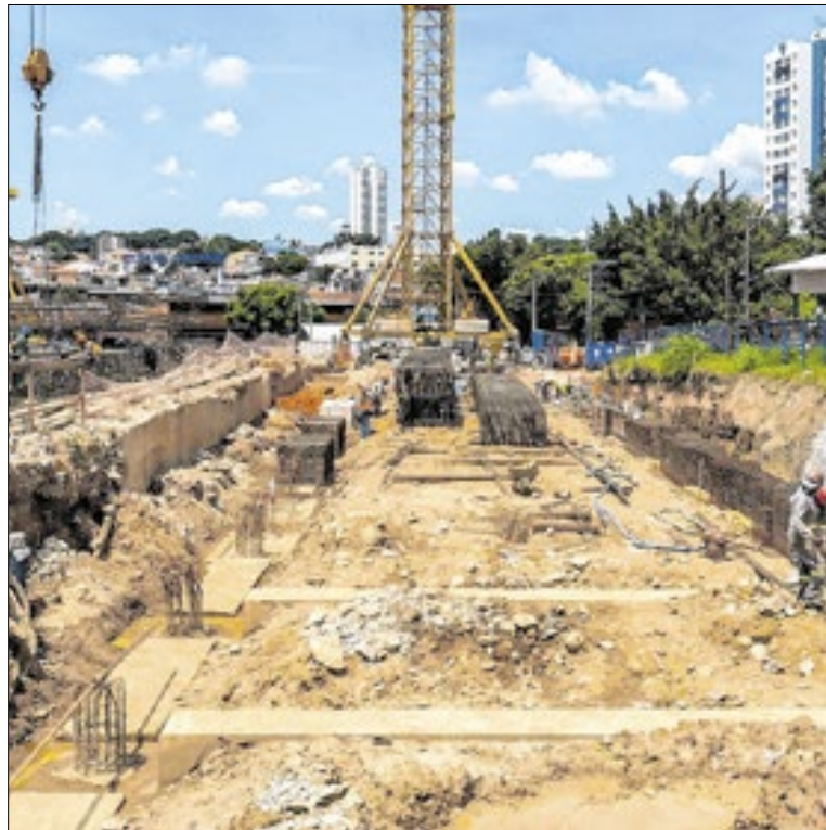
Obras no Complexo Rapadura, na expansão da linha 2 verde, em São Paulo
