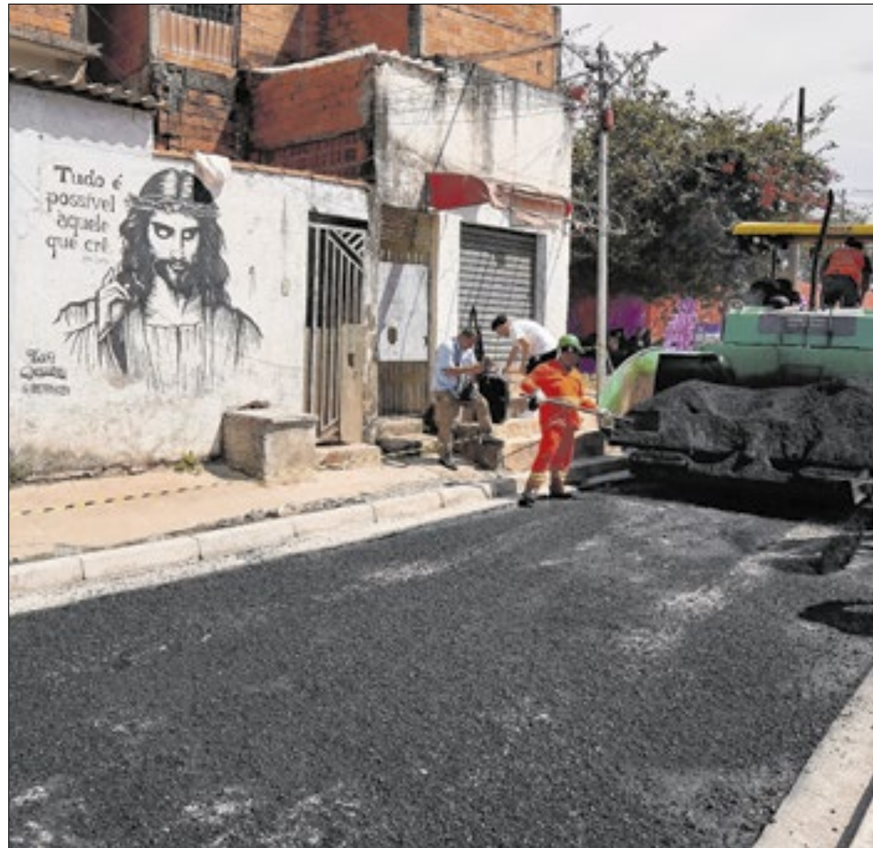
Visita às Obras de Pavimentação do Programa Renova Ruas e Visita à Conclusão de Obras de Recuperação Estrutural do Córrego Itaim
