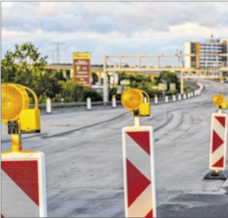
Obra para conter erosão provoca mudança no acesso a Cosmópolis
