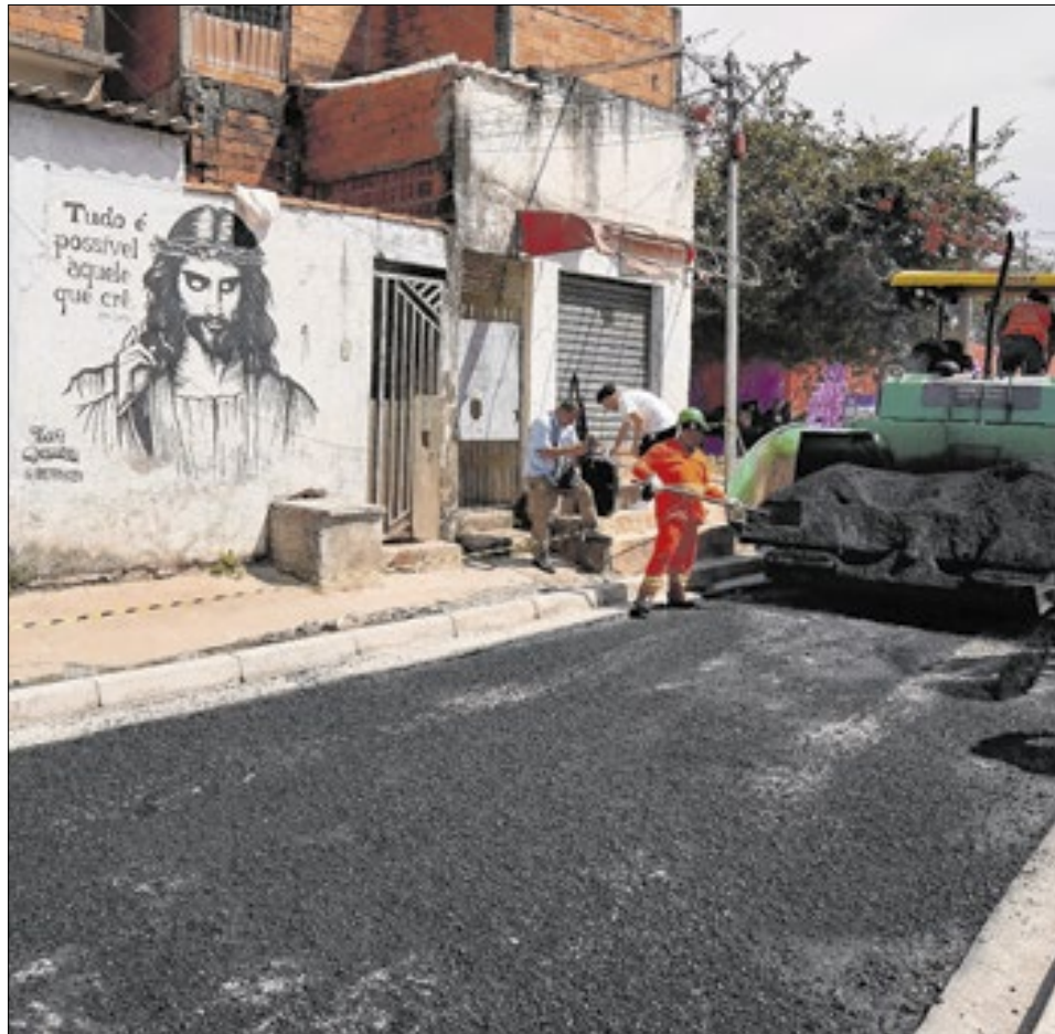
Visita às Obras de Pavimentação do Programa Renova Ruas e Visita à Conclusão de Obras de Recuperação Estrutural do Córrego Itaim
