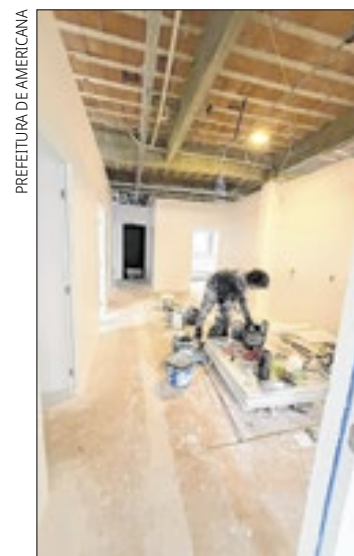
As obras de construção entraram na fase de pintura
