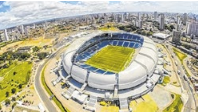
Linhas extras facilitarão o acesso do torcedor à Arena das Dunas
