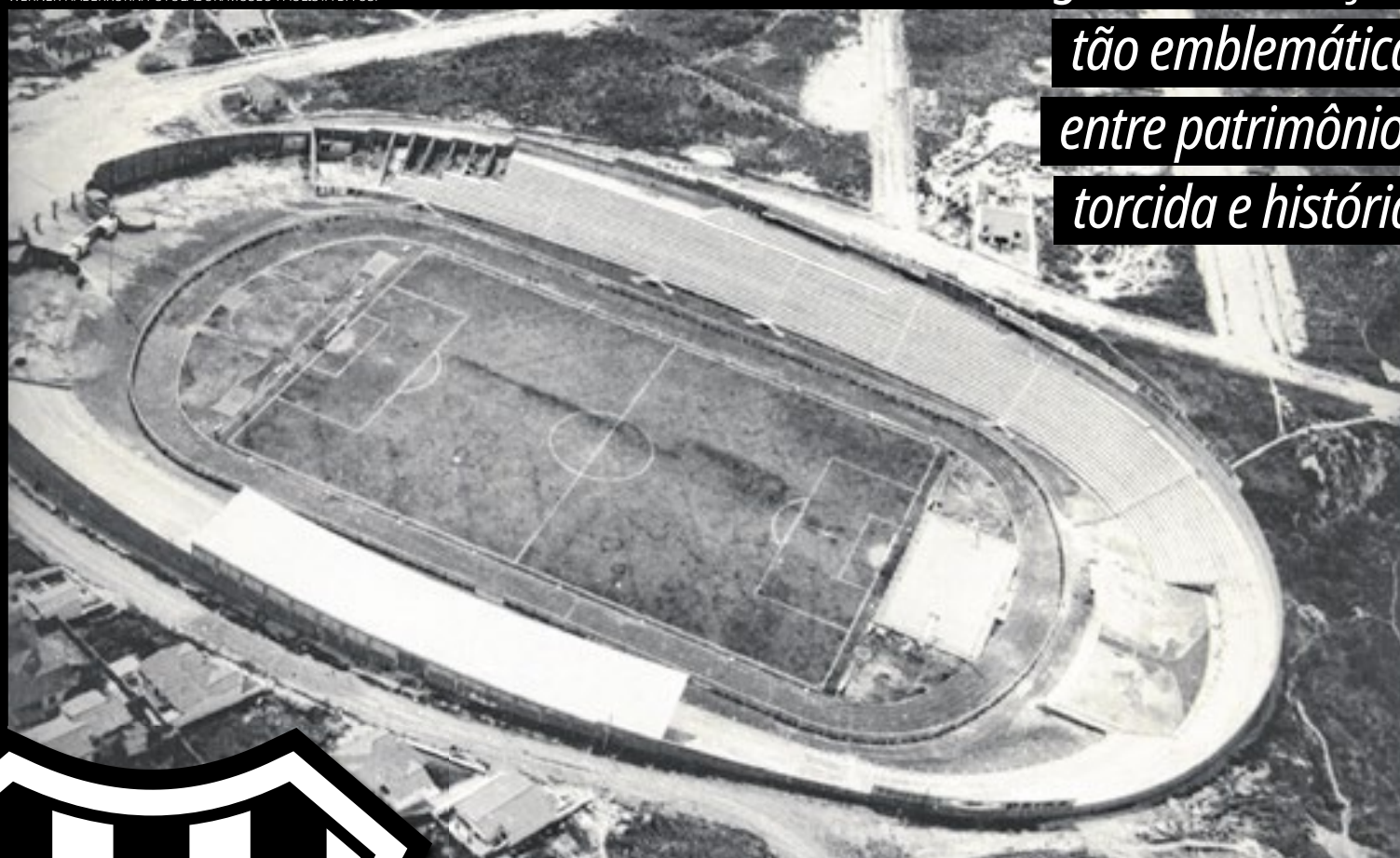
Imagem aérea do Estádio Moisés Lucarelli, o Majestoso, ainda em obras, no bairro Ponte Preta da Ponte, em Campinas, na Praça Dr. Francisco Ursaia, 1900, em Campinas
