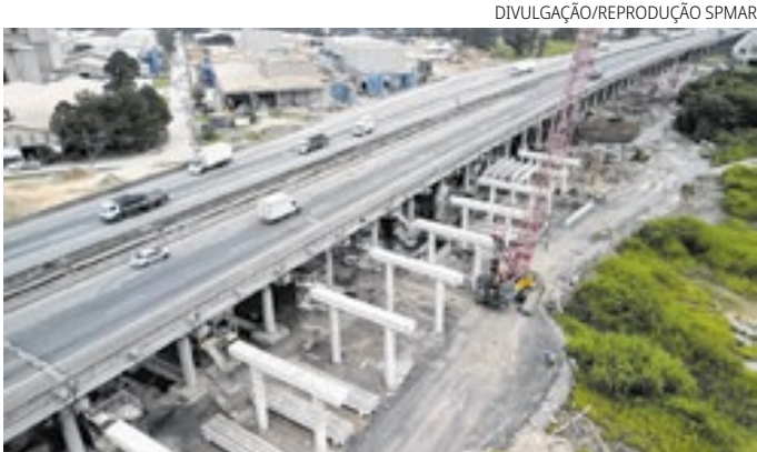
Prefeito de Poá vistoriou as obras do Complexo Viário do Alto Tietê
