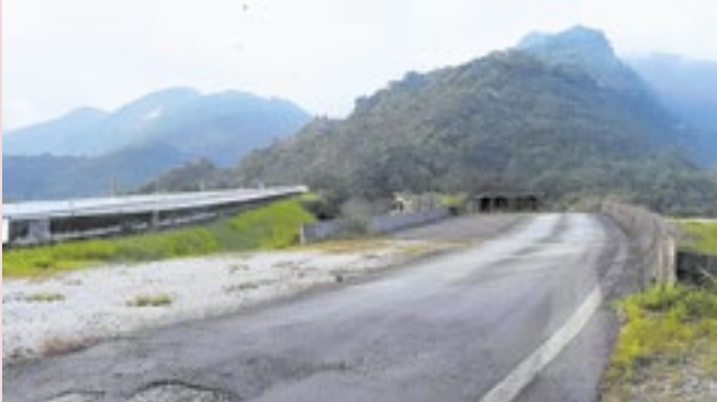
Documento aponta obras da Subida da Serra, na BR-040
