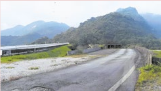
Documento aponta obras da Subida da Serra, na BR-040
