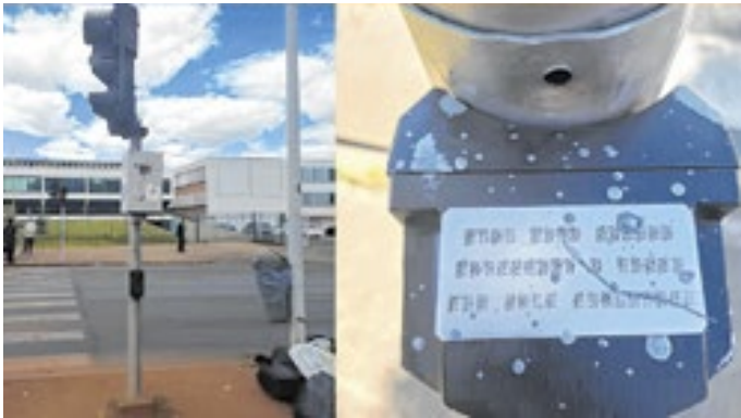
Os 12 pontos fiscalizados estão em desacordo com as normas
