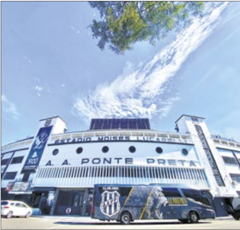
Estádio Moisés Lucarelli, sede da Associação Atlética Ponte Preta
