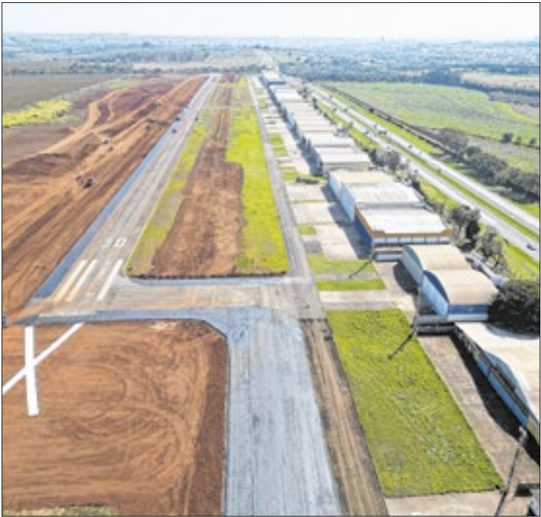
Obras visam a ampliação da capacidade operacional do aeroporto
