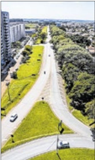
Obra terá 1,2 km de extensão total e duas novas passarelas
