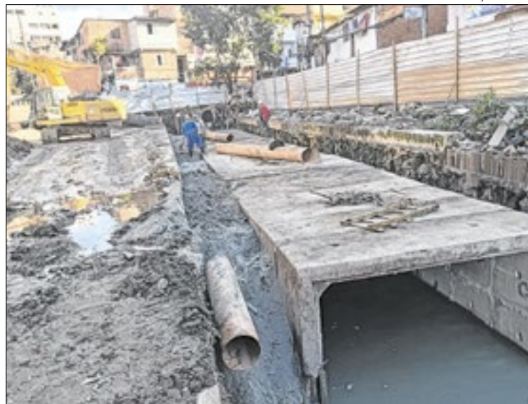
Instalação da rede de esgoto na comunidade da Zona Sul da capital
