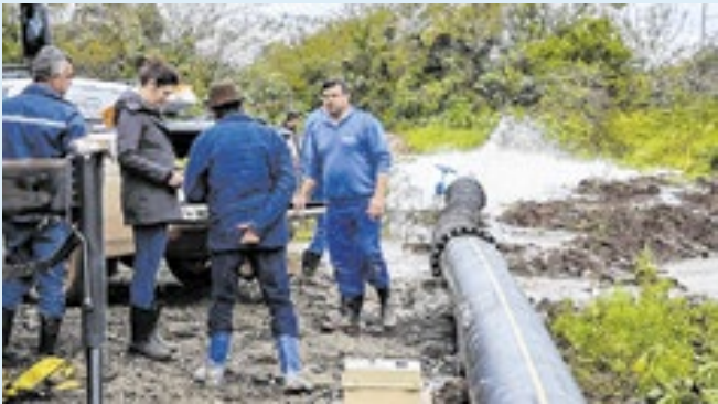
Foram instalados dispositivos flutuantes que podem ser deslocados
