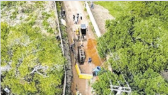
Autoridades vistoriam obras do novo sistema de esgoto na Varginha
