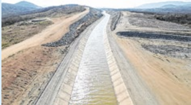
Obras integram ações de ampliação e segurança
