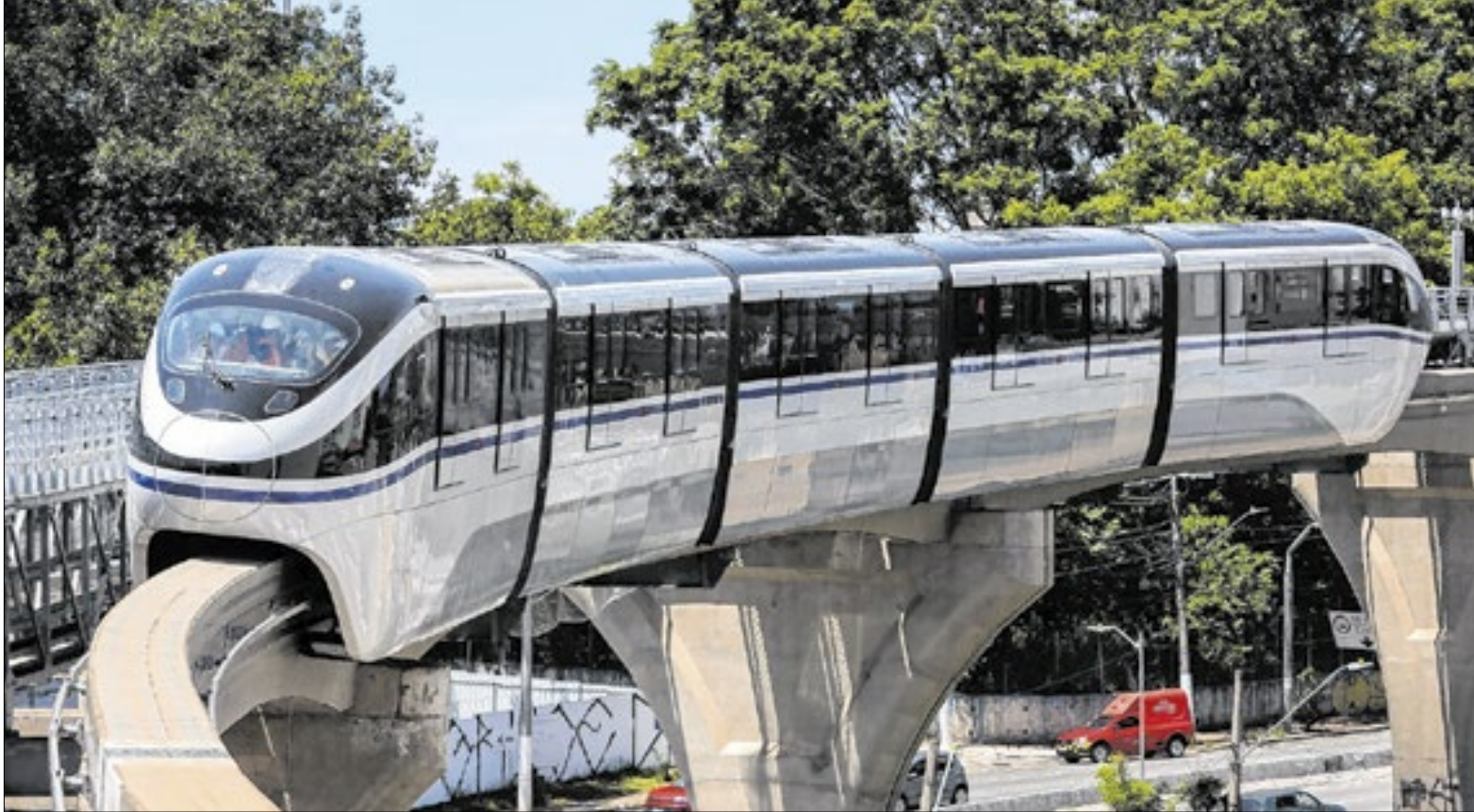
Obras da Linha 17-Ouro do Metrô de São Paulo foram registradas como atrasadas no Painel do TCE-SP em 25 de abril; parte do projeto foi concluído em março
