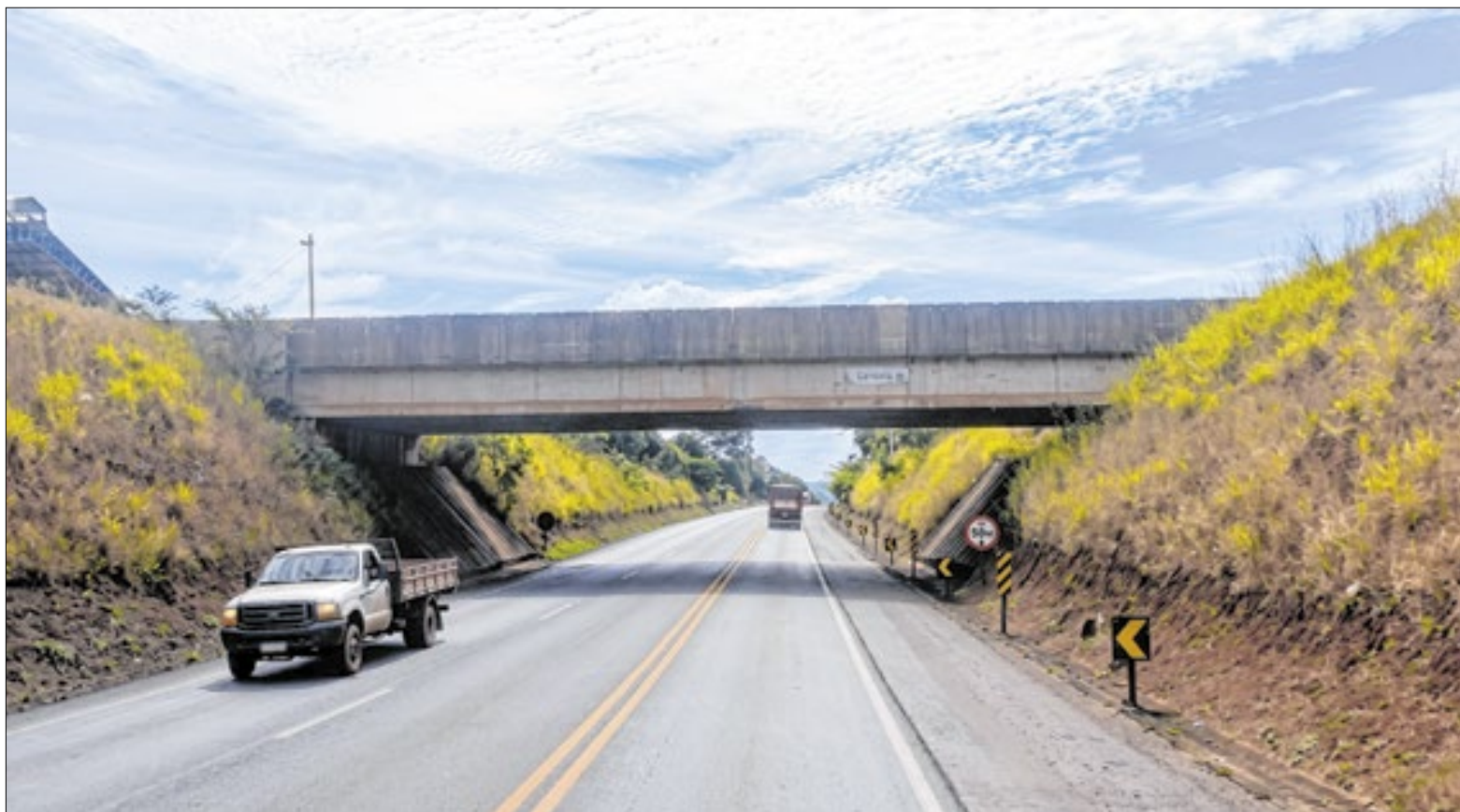
Obra com valor mais alto é a recuperação de viaduto de passagem superior em Colômbia/SP, na região de Barretos, com valor de R$ 856,7 mil
