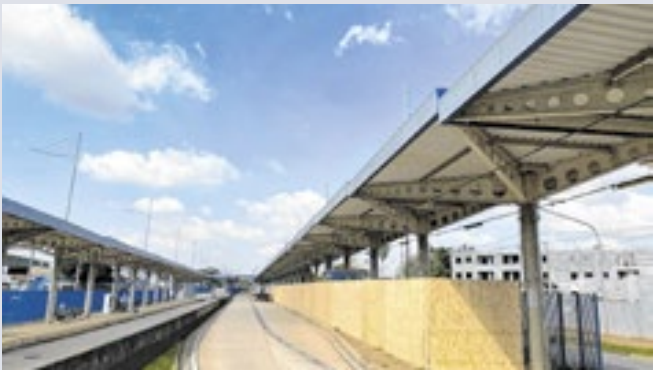
Projeto amplia a estrutura e a instalação de novos carregadores
