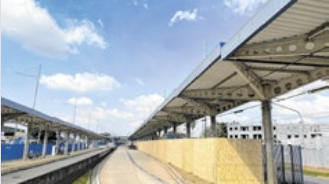
Projeto amplia a estrutura e a instalação de novos carregadores
