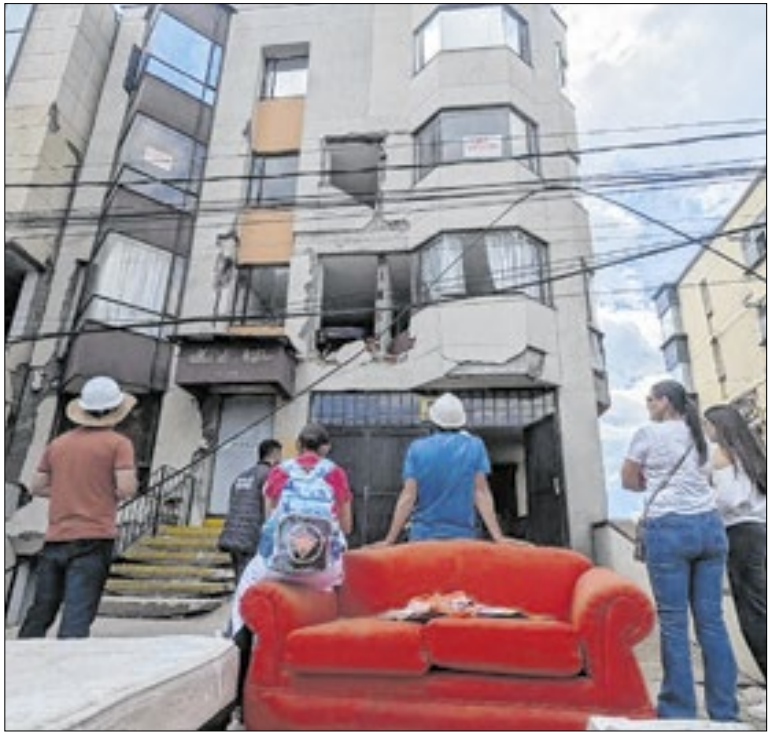
Pessoas em frente a prédio com danos estruturais em Manizales
