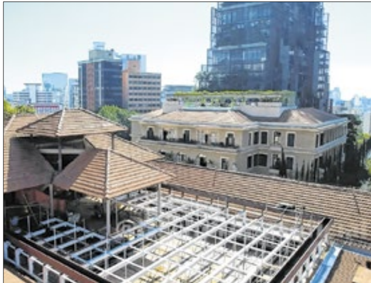
Vista do complexo Cidade Matarazzo, onde antes havia um hospital
