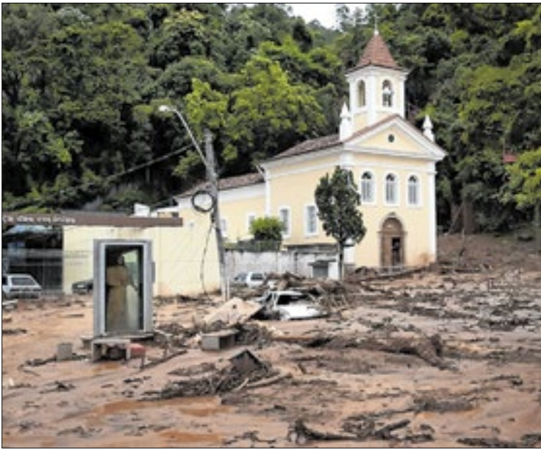
Igreja de S. Antônio atingida pelo deslizamento provocado pela chuva
