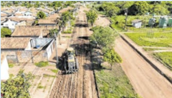
Ao todo, serão mais 2.435 metros de pavimentação
