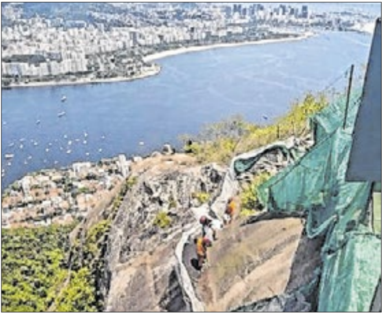
MPF sustenta que a intervenção atingiu área protegida por tombamento
