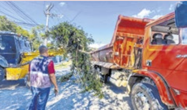
Secretarias de Serviços Públicos e de Obras seguem atuando
