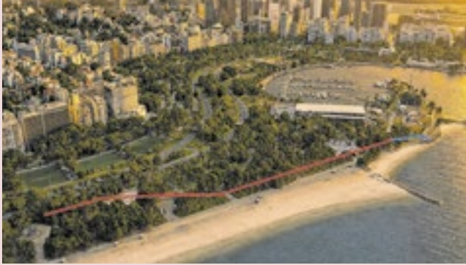
Trecho tem serviços de limpeza, desassoreamento e recuperação
