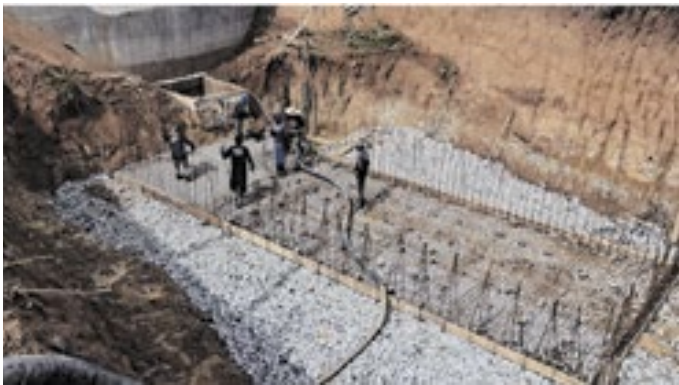
Obra integra pacote para ampliar a oferta de água tratada
