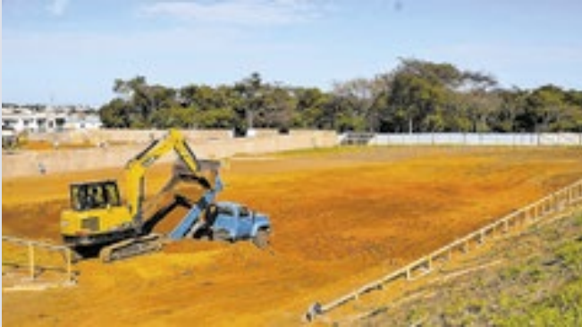
Já foram concluídos os serviços de instalação do canteiro e tapumes
