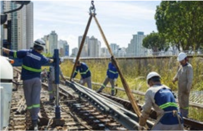
O Metrô-DF informou que os trilhos passarão por substituição
