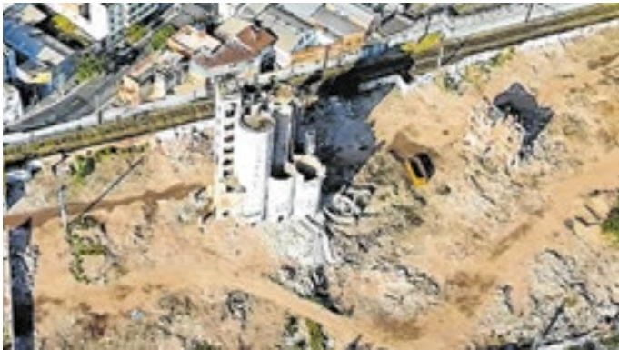
Moinho que deu nome à favela começa a ser demolido
