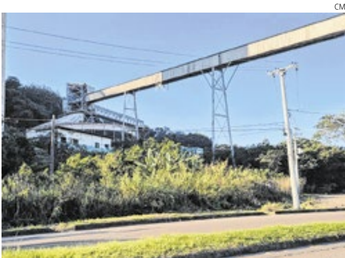
Porto de Itaguaí sendo alvo de desmonte de estruturas
