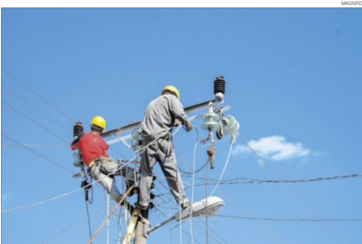
Funcionários trabalham em instalação de energia elétrica: motoristas devem reduzir a velocidade no trecho
