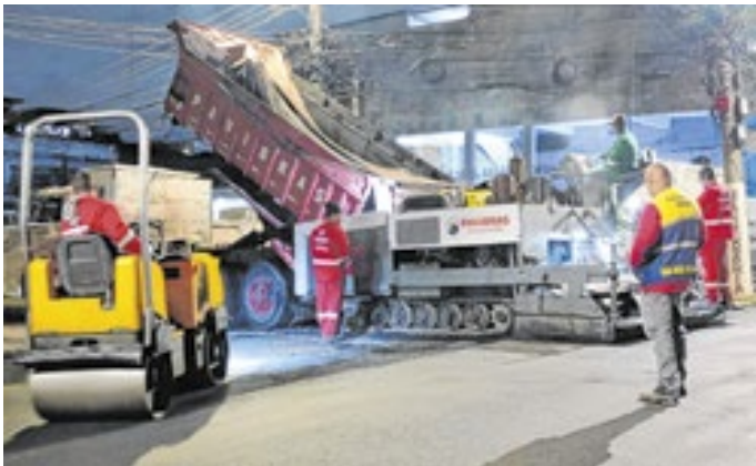
Homens e máquinas aplicaram uma nova camada de asfalto na rua
