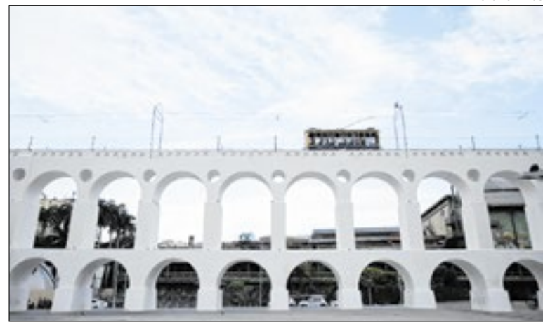
Obra incluiu limpeza, pintura e recuperação total da Praça Cardeal Câmara
