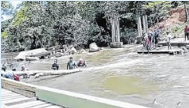
A ponte de madeira foi construída há três anos
