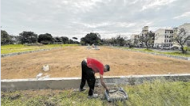
Estádio está sendo construído na Rua Francisco Carlos Maciel
