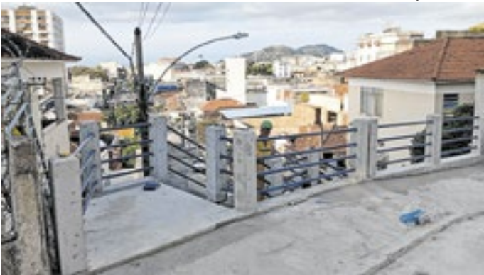
Obras melhoraram o acesso de moradores e a estabilização da encosta
