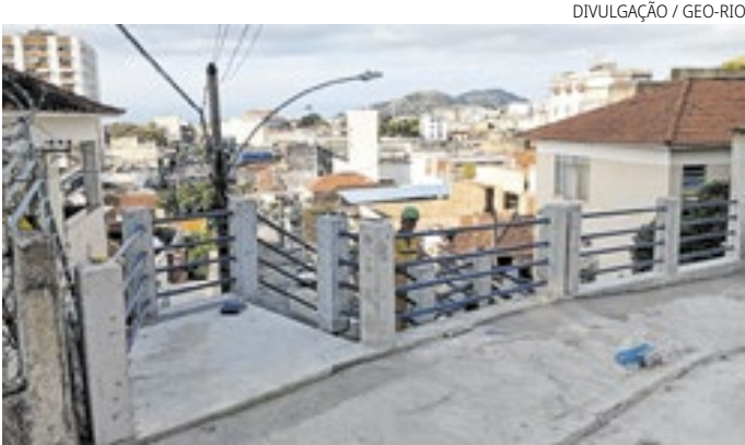
Obras melhoraram o acesso de moradores e a estabilização da encosta
