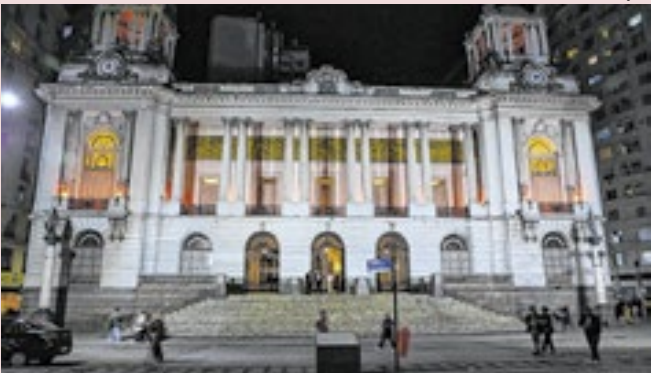
Fachada do Palácio Pedro Ernesto recebe iluminação laranja
