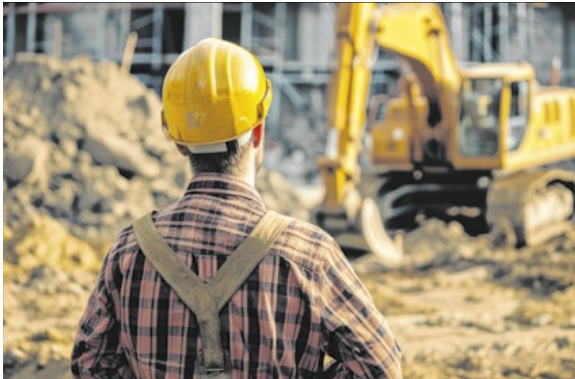
Engenheiro na obra: conjunto de intervenções inclui cortes, aterros, nivelamento, compactação do solo, entre outros
