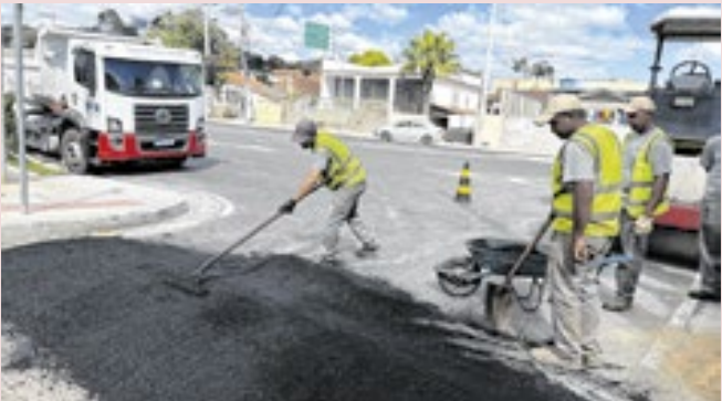
Instalação ocorreu nas proximidades do novo Complexo Viário
