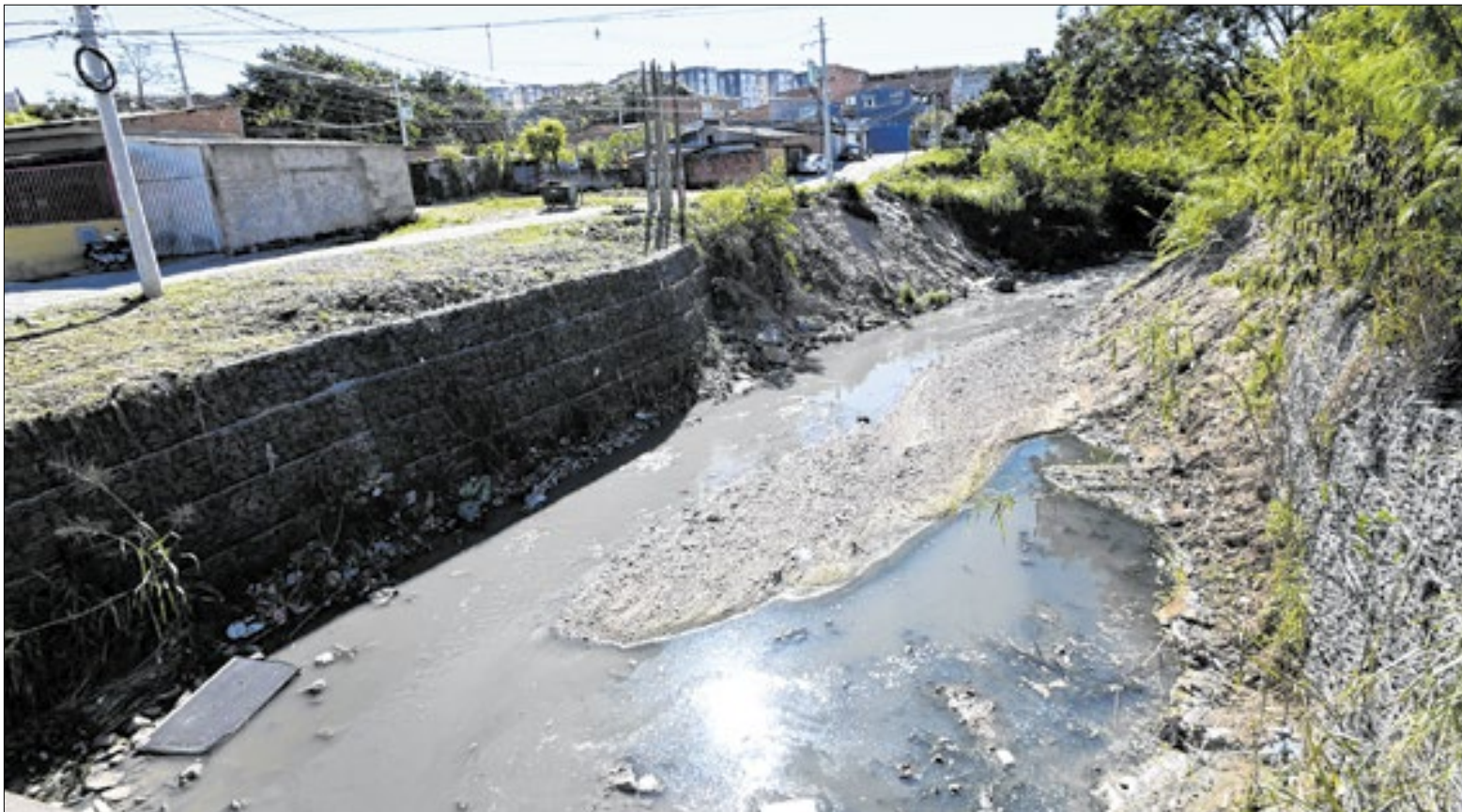
As obras serão realizadas em um trecho de 1.819,70 metros
