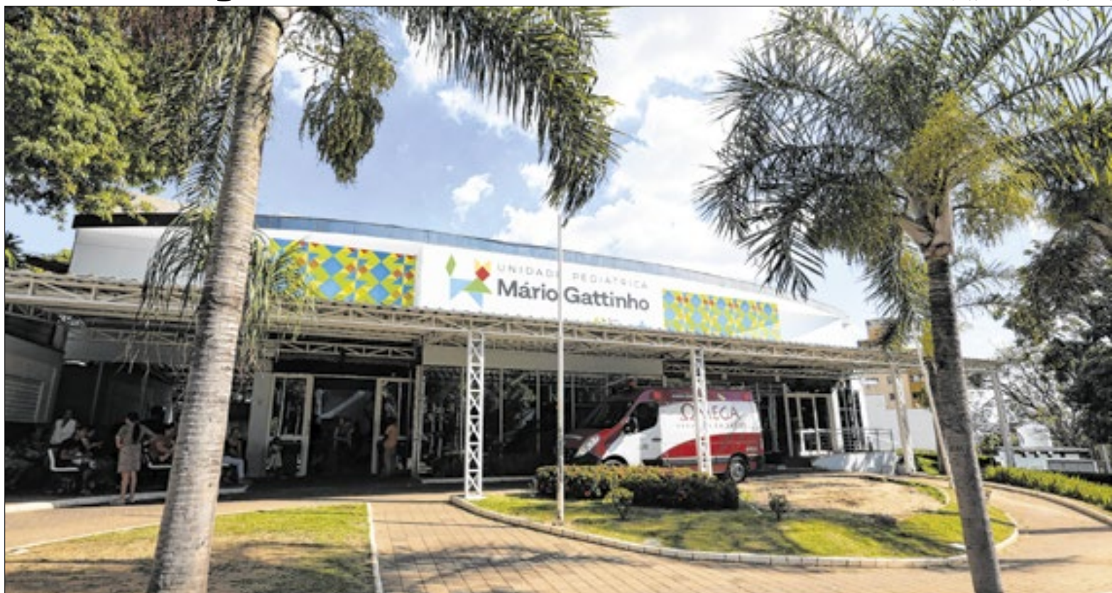
A Vigilância Sanitária de Campinas interditou o equipamento de termodesinfecção da Central de Material e Esterilização (CME) da Unidade Pediátrica Mário Gattinho
