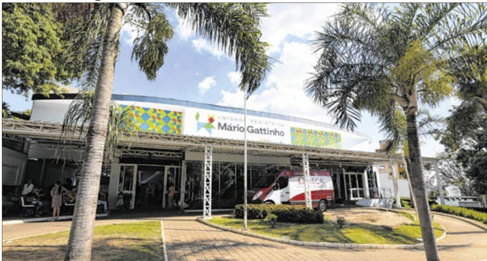
A Vigilância Sanitária de Campinas interditou o equipamento de termodesinfecção da Central de Material e Esterilização (CME) da Unidade Pediátrica Mário Gattinho
